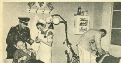
Für erste ärztliche Behandlung sind in dem Hirtenbau des Stadions mehrere mit den modernsten medizinischen Apparaten ausgestattete Sanitätsräume vorhanden.
