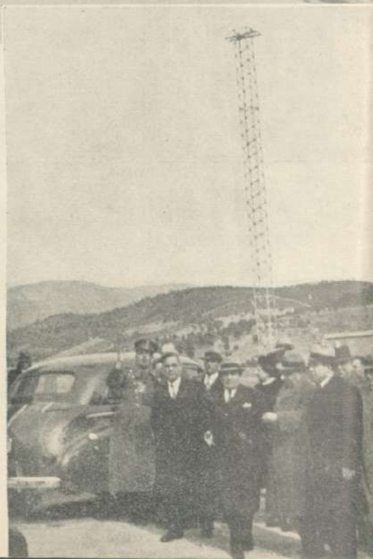
Ἀπὸ τὰς νέας τηλεπικοινωνιακὰς ἐγκαταστάσεις τῆς Ἑλλάδος, ἓνα ἀπὸ τὰ πλέον συγχρονισμένα ἔργα τῆς Ἐθνικῆς Κυβερνήσεως: Ἄνω: τὸ κεντρικὸν Ἰδρυμα τοῦ Σταθμοῦ καὶ κάτω: ὁ πομπὸς λήψεως τοῦ Χαρβατίου.
